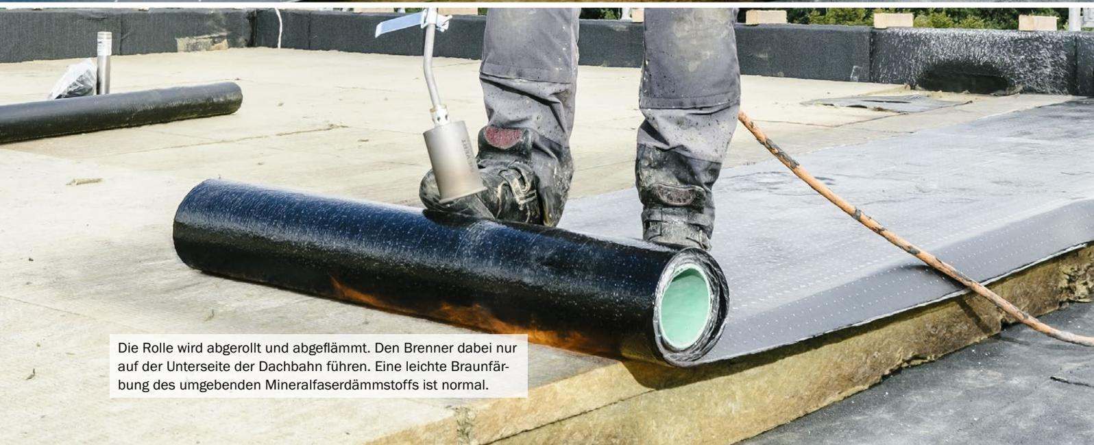
Die Rolle wird abgerollt und abgeflämmt. Den Brenner dabei nur auf der Unterseite der Dachbahn führen. Eine leichte Braunfärbung des umgebenden Mineralfaserdämmstoffs ist normal.
