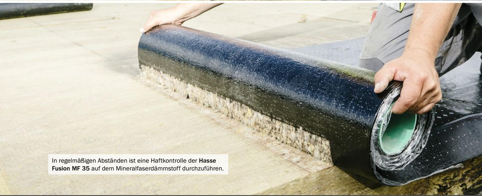
In regelmäßigen Abständen ist eine Haftkontrolle der **Hasse Fusion MF 35** auf dem Mineralfaserdämmstoff durchzuführen.
