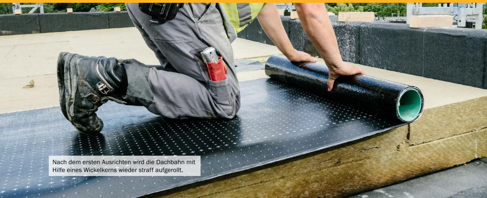
Nach dem ersten Ausrichten wird die Dachbahn mit Hilfe eines Wickelkerns wieder straff aufgerollt.
