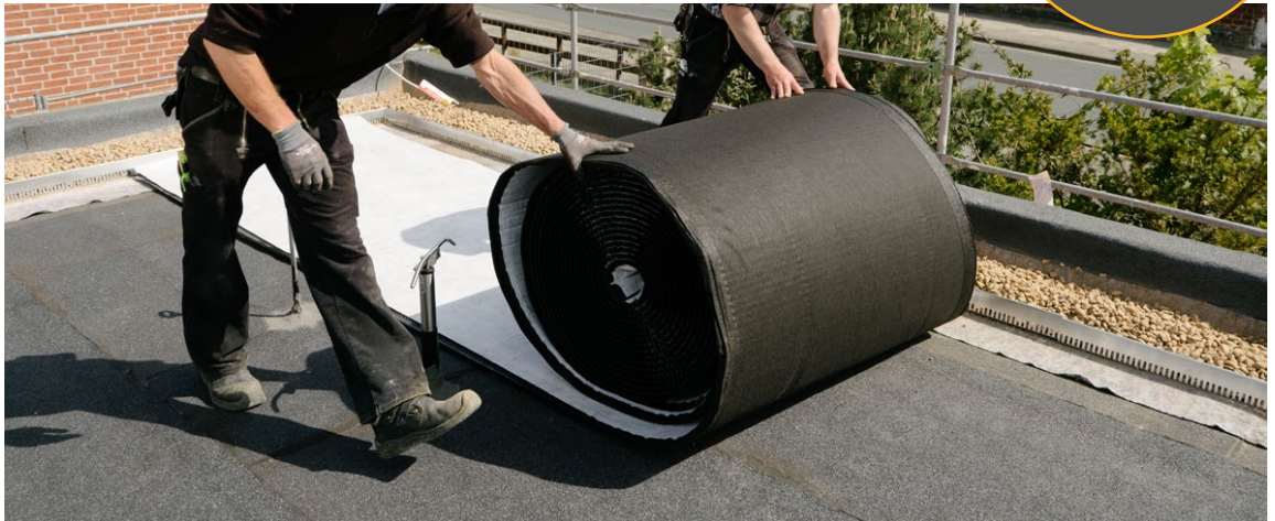
1. Hasse Kombidrain Rolle positionieren, ausrollen und umdrehen. Das schwarze Vlies muss oben sein.
