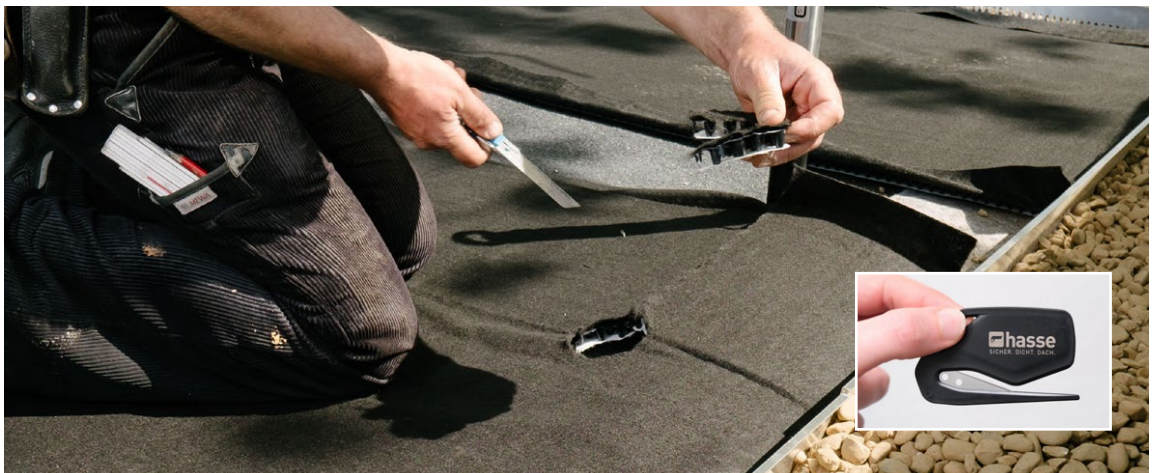
3. Der Zuschnitt von Hasse Kombidrain kann mit einem normalen Messer oder dem speziellen Hasse Messer erfolgen. Nachfolgend wird beispielsweise Hasse Extensivsubstrat aufgetragen oder die Hasse Substratersatzmatte verlegt.
