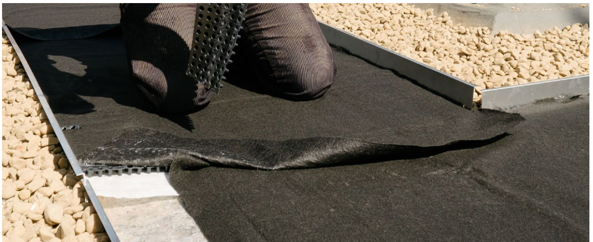
2. Der nächste Abschnitt wird direkt aneinander gelegt. Das schwarze Filtervlies muss dabei überlappen. Wenn nötig, muss die Drainplatte gekürzt werden, um eine ausreichende Überlappung gewährleisten zu können.
