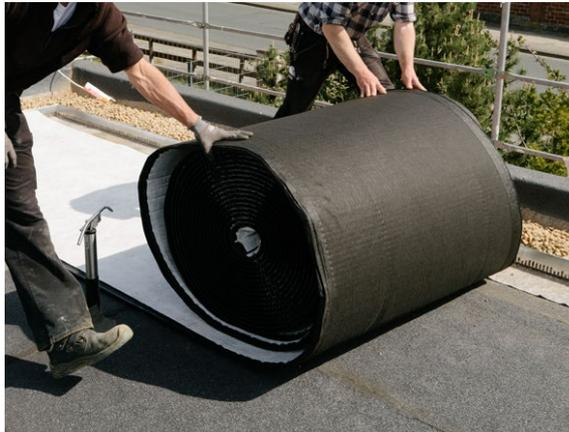
1. Hasse Kombidrain Rolle positionieren, ausrollen und umdrehen. Das schwarze Vlies muss oben sein.
