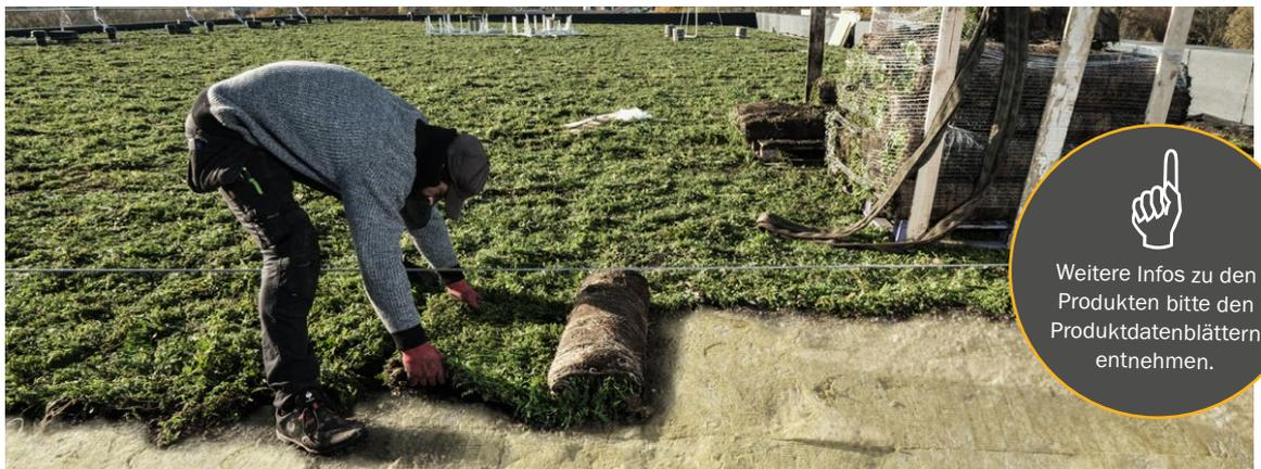
5. Die Hasse Vegetationsmatten sind bei der Verarbeitung schonend zu behandeln. Die Verlegung sollte im versetzten Verband erfolgen. Um spätere Rückstellungen zu vermeiden darf kein Zug auf die Hasse Vegetationsmatten ausgeübt werden. Hohlräume und Mulden eventuell mit losem Substrat auffüllen und anschließend die Fläche mit einer Rasenwalze leicht andrücken. Je nach Vegetationsmatte kann eine durchgehende Schicht Substrat nötig sein.
