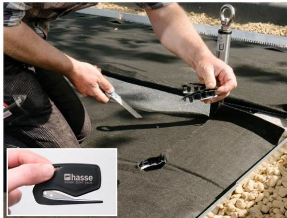
3. Der Zuschnitt von Hasse Kombidrain kann mit einem normalen Messer oder dem speziellen Hasse Messer erfolgen.
